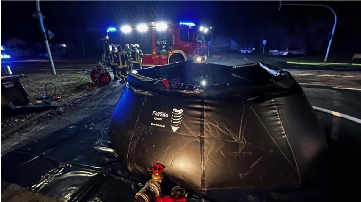
Ein mobiler Wasserspeicher wird auf der B73 aufgebaut. Foto: Vasel
